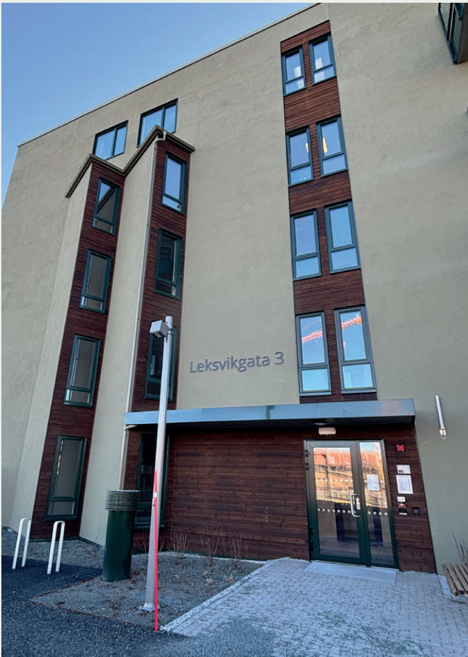
Hovedinngangen fra nord. Det er laget karnapper av hensyn til blokka som kommer vinkelrett ut for Ståлтаугen 3.
